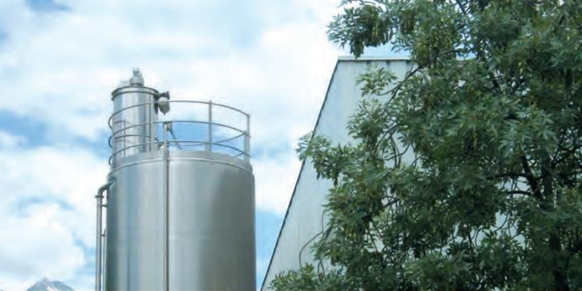
Silos esterni in acciaio inossidabile con cono vibrante o letto fluido per il completo scarico cronologico del prodotto.
