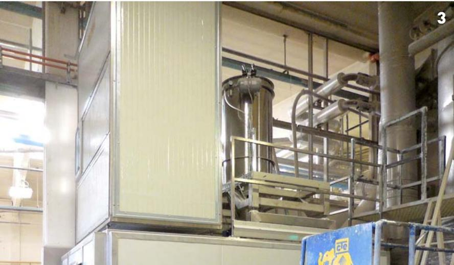
Sistema CEPI basato sullo scambio d'aria raffreddata e iniettata nel silo attraverso letto fluido. Rende possibile il raggiungimento graduale della temperatura impostata.
