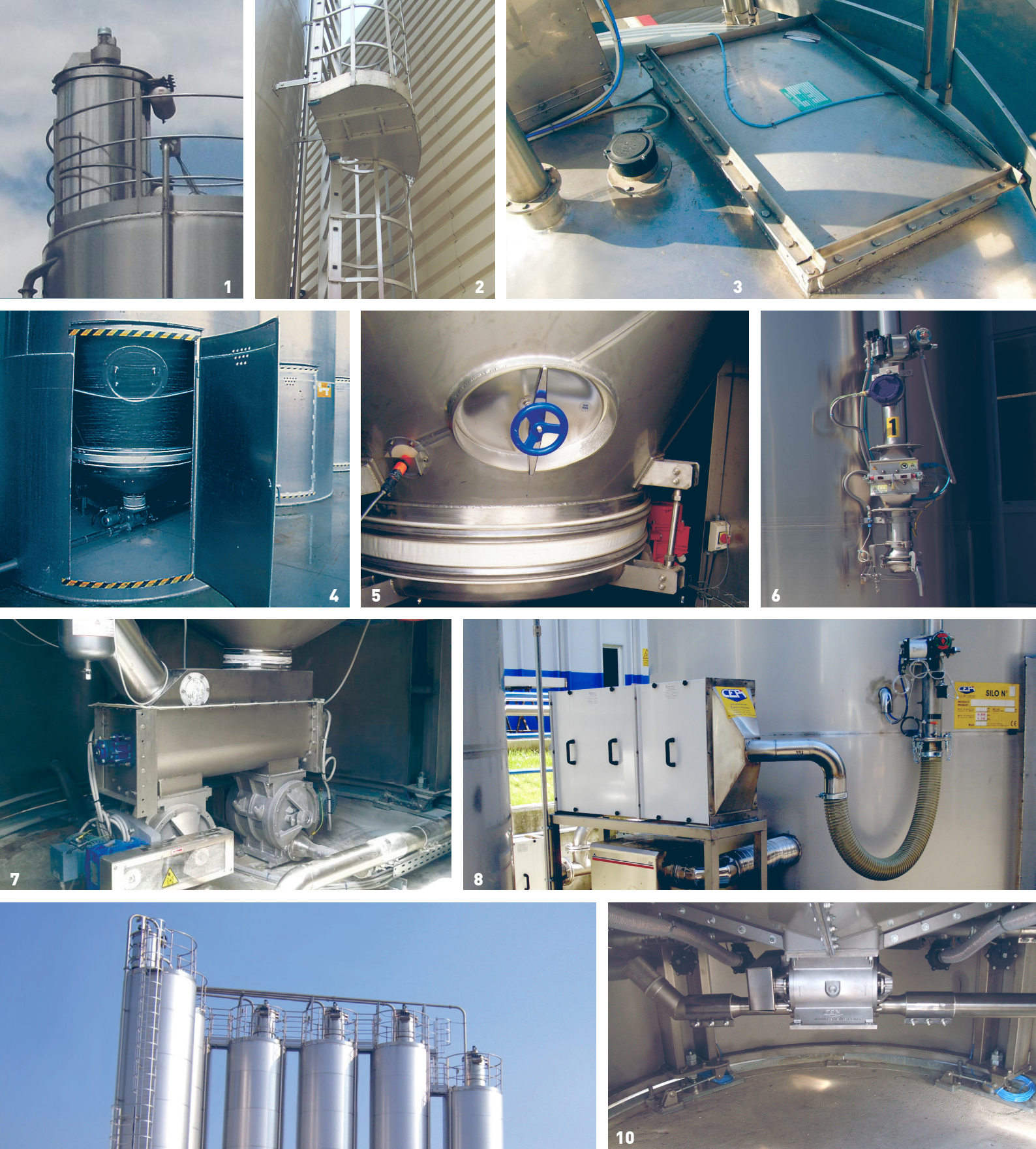
1 Filtro di recupero polveri a norma 2 Scala di accesso alla parte alta e ringhiera di protezione a norma EU 3 Pannello antiesplosione 4, 5 Estrazione con cono vibrante 6 Sistema di sicurezza CEPATIC per evitare sovrappressione durante il carico 7 Distributore multilinea 8 Sistema anticondensa e deumidificazione 10 Estrazione con letto fluido, pesatura silos con celle e visualizzazione peso in tempo reale SWS
