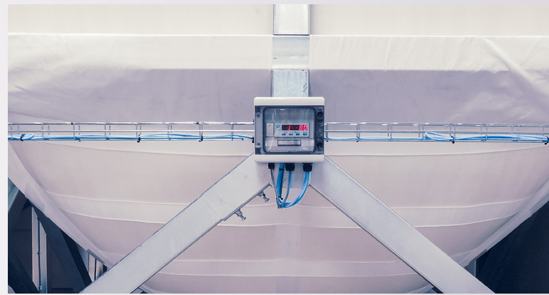
Silssystem con stazione per microingredienti, vibrosetaccio in linea pneumatica e controllo del peso; gruppo Silssystem
