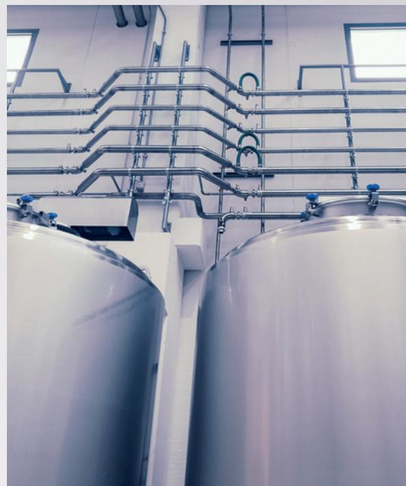
Carico automatico con tubatura riscaldata
