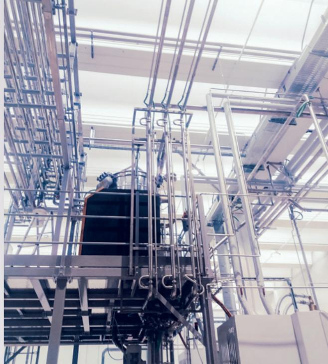
Percorsi ordinati e senza intrecci di intrecci di tubi riscaldati che alimentano un gran numero di serbatoi diversi in più punti. Design igienico e sicuro con tubi verticali a scalare dall'alto.
