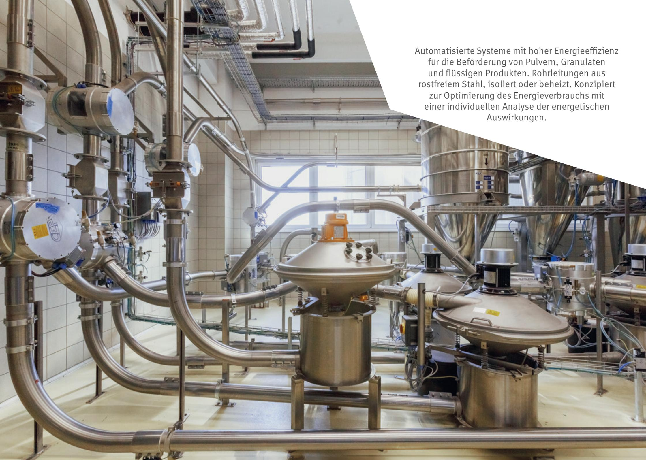
Automatisierte Systeme mit hoher Energieeffizienz für die Beförderung von Pulvern, Granulaten und flüssigen Produkten. Rohrleitungen aus rostfreiem Stahl, isoliert oder beheizt. Konzipiert zur Optimierung des Energieverbrauchs mit einer individuellen Analyse der energetischen Auswirkungen.
