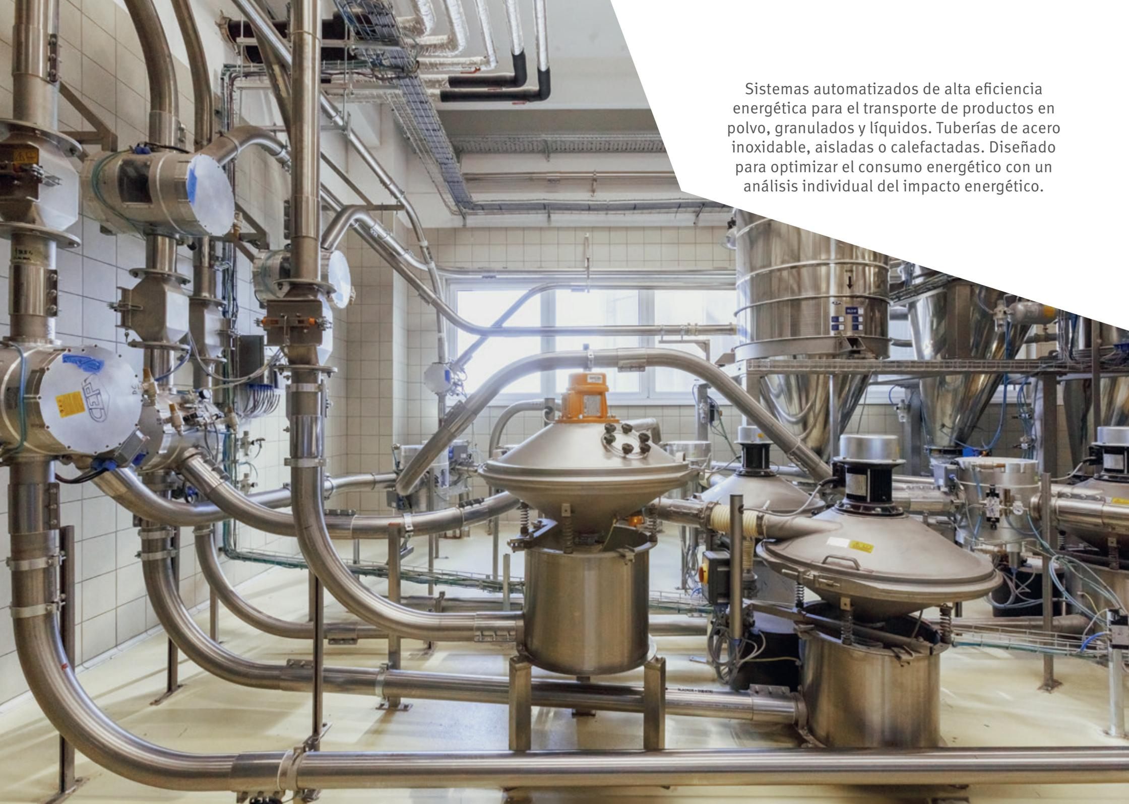
Sistemas automatizados de alta eficiencia energética para el transporte de productos en polvo, granulados y líquidos. Tuberías de acero inoxidable, aisladas o calefactadas. Diseñado para optimizar el consumo energético con un análisis individual del impacto energético.
