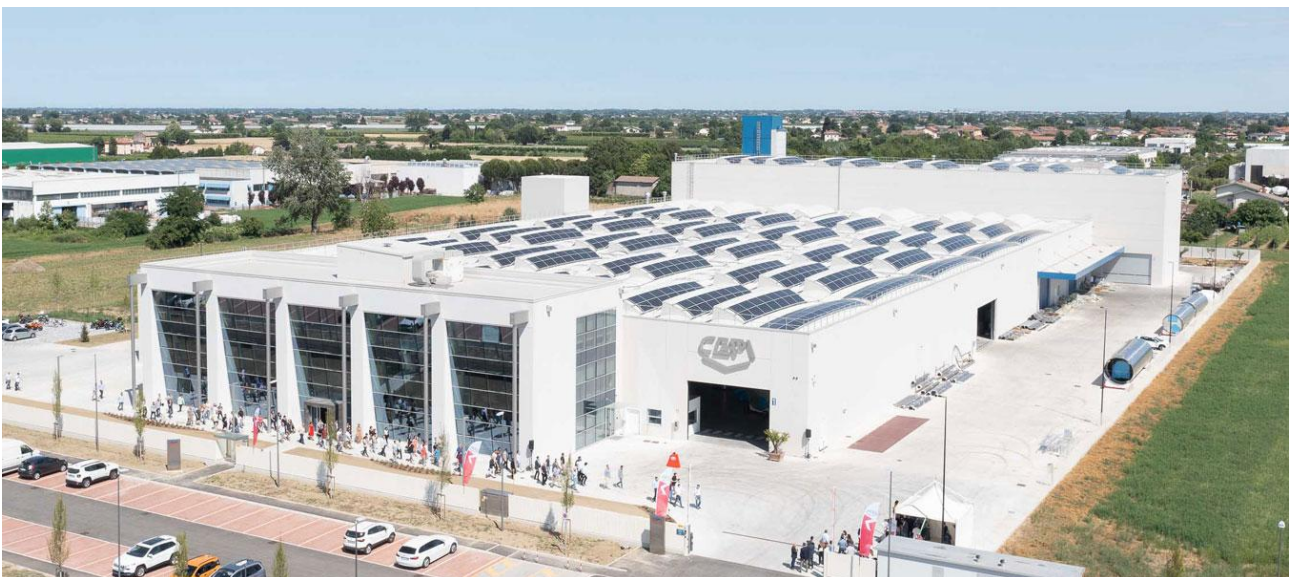
Figura 7: Sede CEPI situata a La Selva (FC)
